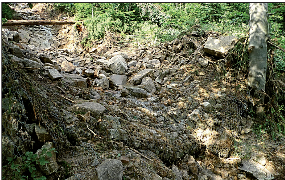
Obr. 5. Charakter tranzitní zóny mury 1 těsně nad silnicí. V popředí muros slisovaná drátokošová (gabionová) protierozní přepážka.
