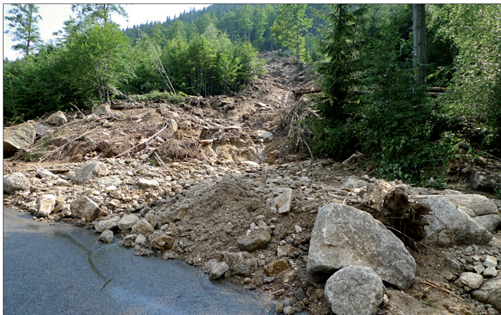
Obr. 10. Dráha mury 2 nad místem, kde poprvé protíná Smědavskou silnici.
